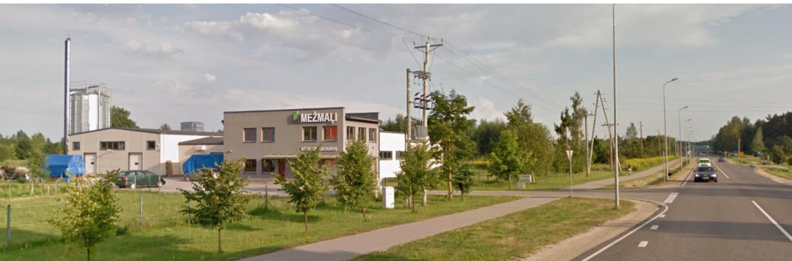
2.attēls. Uzņēmuma SIA “Mežmaļi+” koka logu un durvju ražotne lokālplānojuma teritorijā un pieslēgums valsts vietējam autoceļam V1 “Valdlauči – Rāmava”
